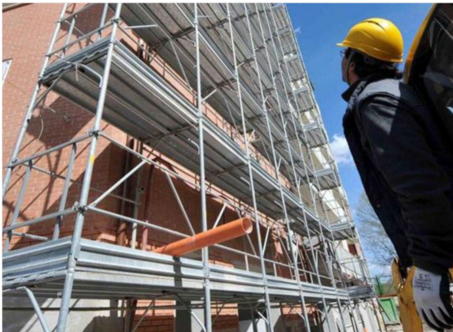
Uno dei tanti cantieri condominiali spuntati in provincia per effetto degli incentivi
